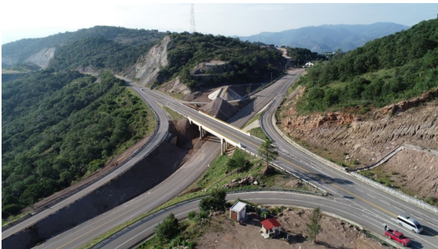
Imagen 4. Panorámica de la carretera Mitla-Tehuantepec. Fuente: SICT.
