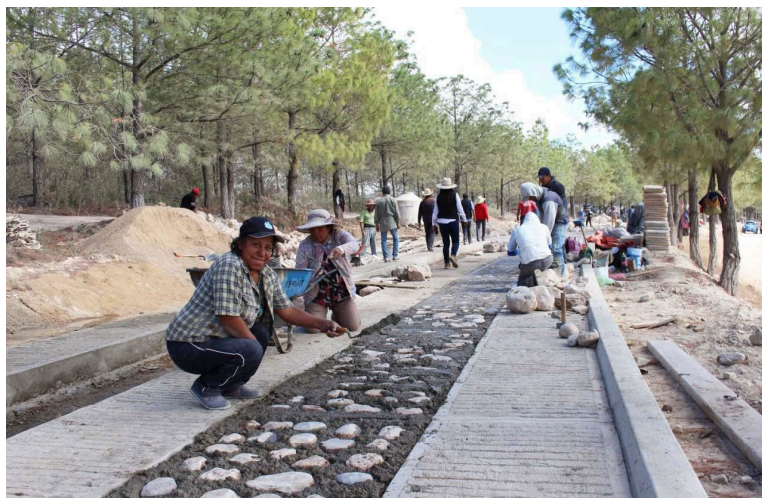
Imagen 14. Construcción de la pavimentación de caminos a cabeceras municipales. Fuente: SICT.
