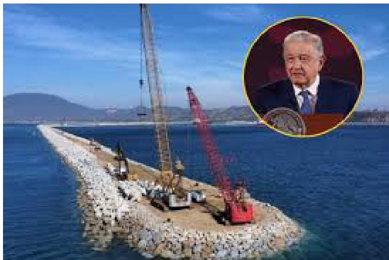
Imagen 9. Construcción del rompeolas de Salina Cruz.
