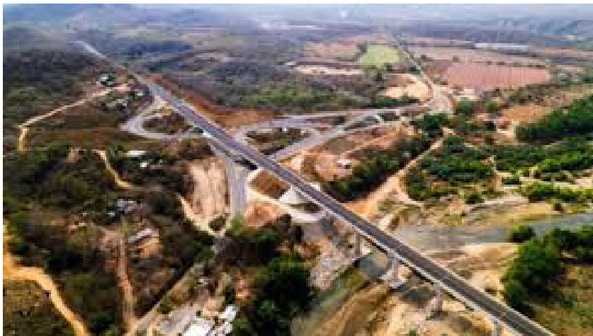
Imagen 2. Panorámica de la carretera Barranca Larga – Ventanilla. Fuente: SICT.
